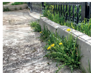
Bordures et trottoirs
